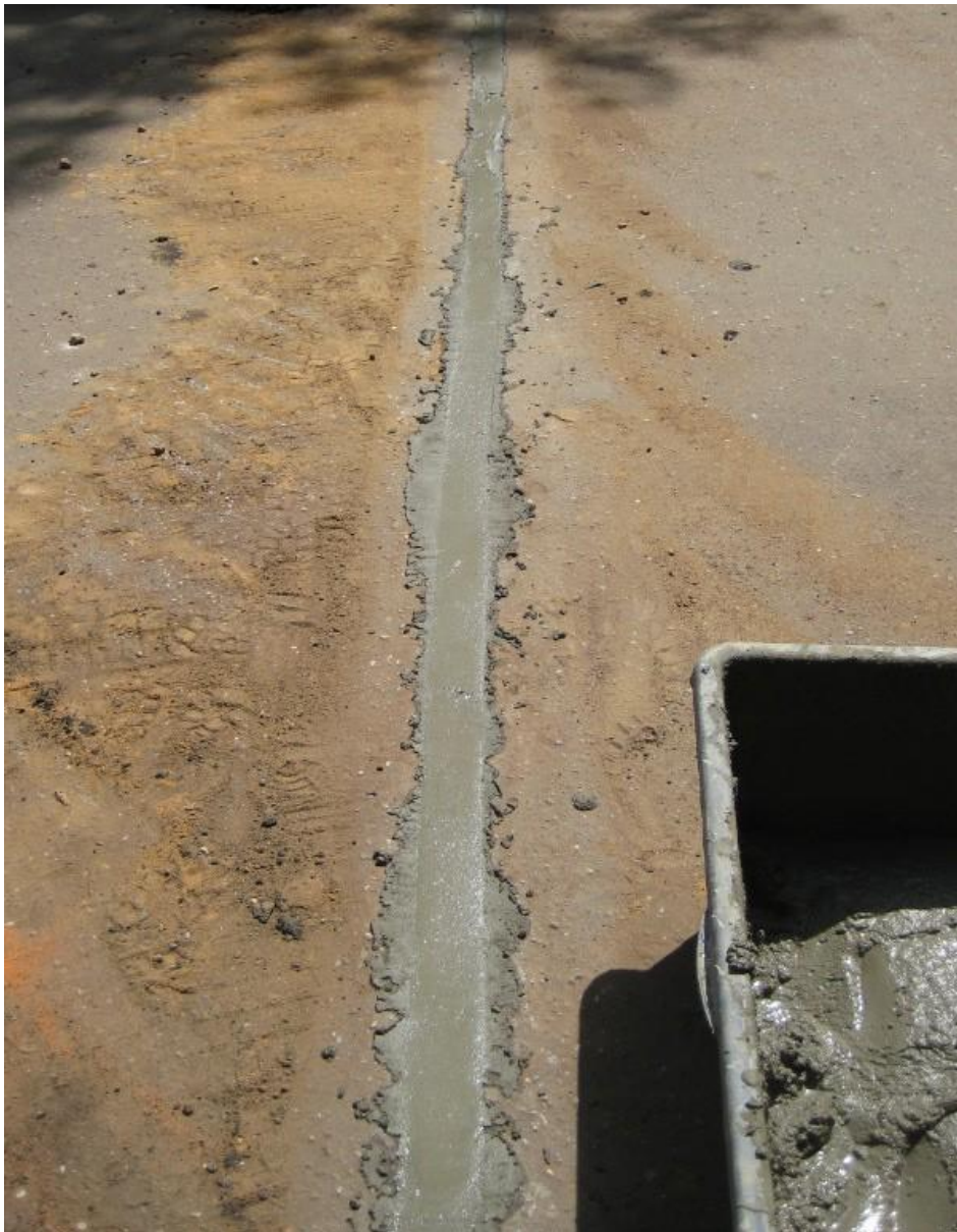
Штроба тщательно заделывается бетоном, под толстым слоем которого кабель надежно защищен от внешних воздействий.
