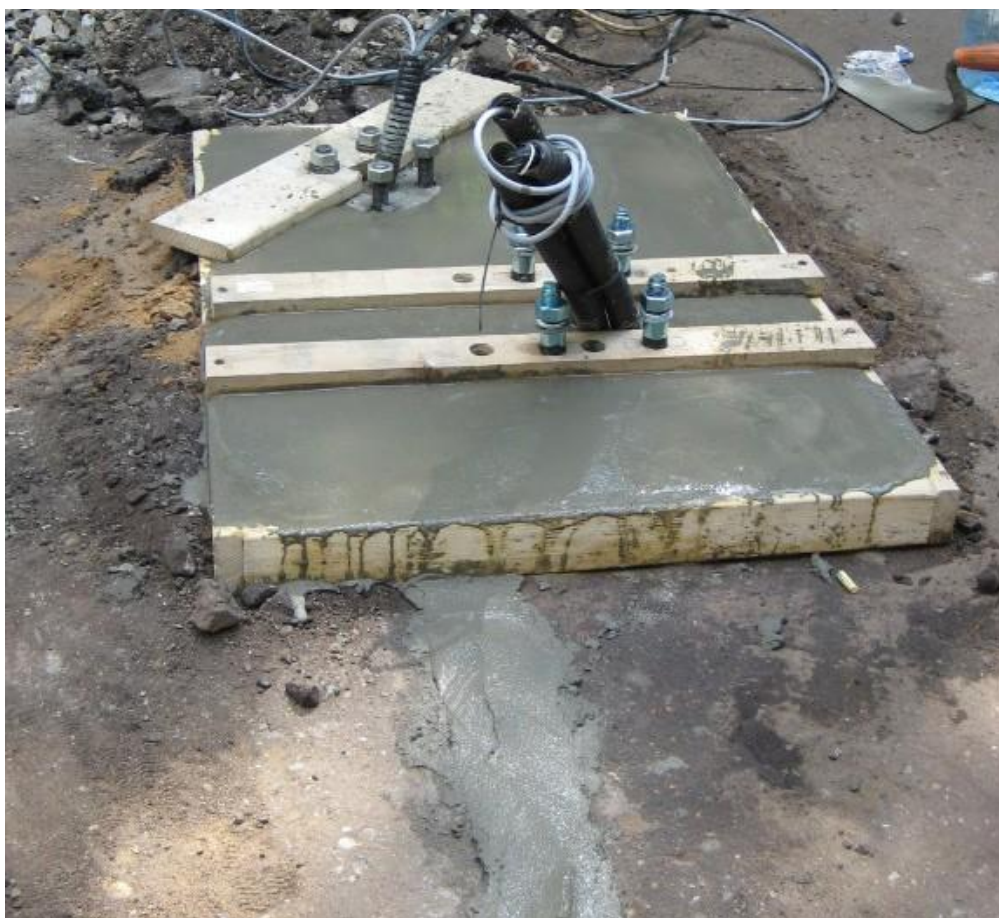
Поверхность выравнивается и устанавливаются элементы крепления шлагбаума и мачты.
