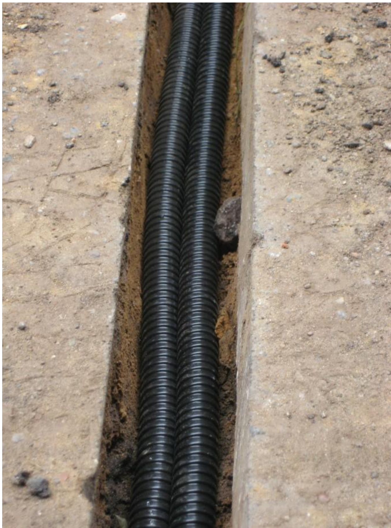
Мы делаем глубокую штробу в асфальте для прокладки кабелей, которые также защищены трубой ПНД с металлической основой.
